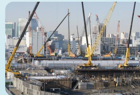
建築工事現場
