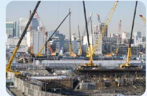
建築工事現場
